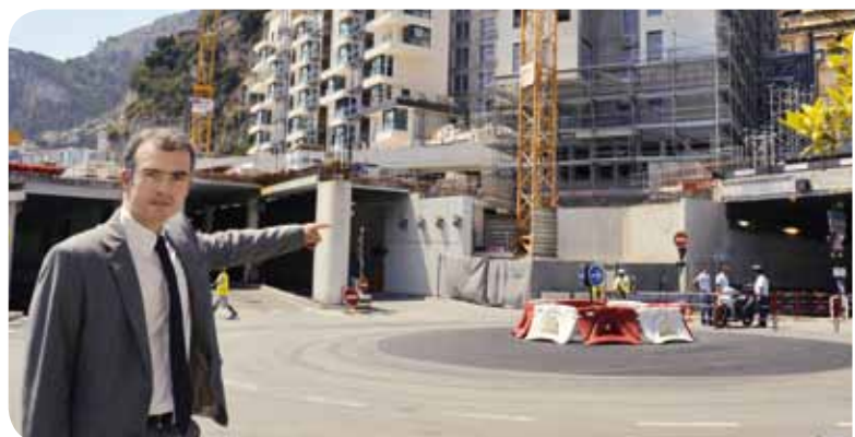
Luc Leroy face aux travaux de finition du parvis Canton
